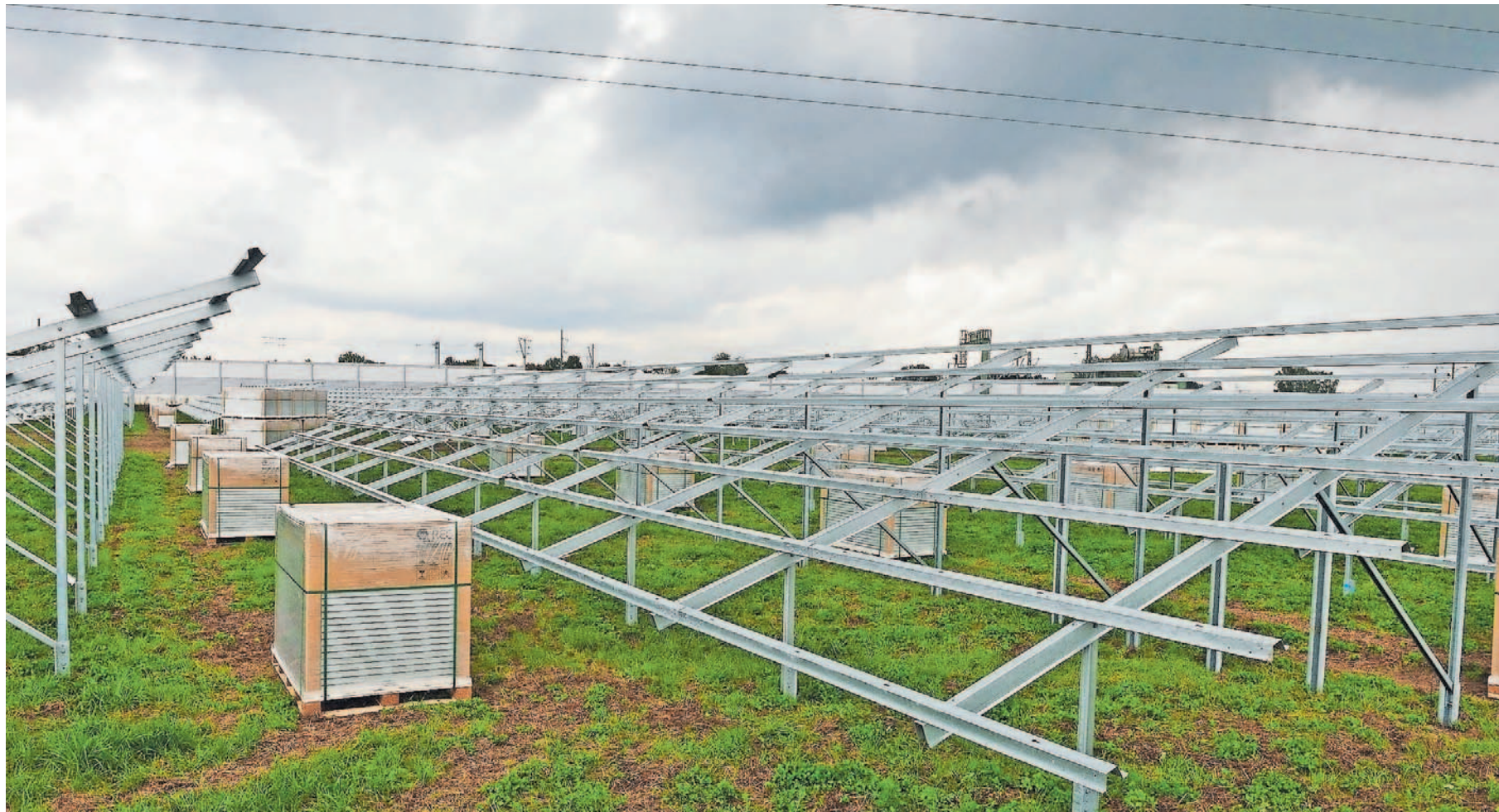
Die Solaranlage in Bubenreuth ist bereits im Bau. Wenn alles klappt, soll sie bereits im Oktober ans Netz gehen. Foto: Klaus-Dieter Schreier
